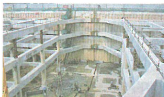
不放坡明挖基坑
