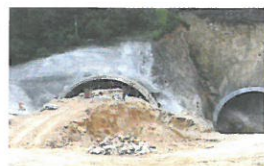
管棚支护完成
