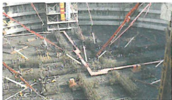
施作基坑底板结构
