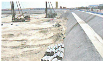
放坡明挖基坑
