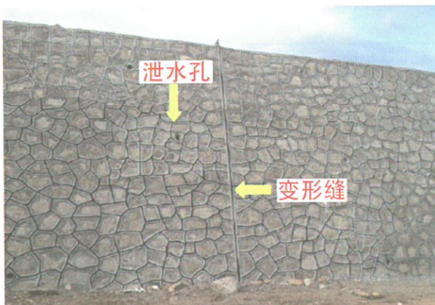
浆砌块石挡土墙
