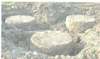
浅部开挖桩头检查
