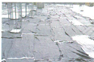
保湿覆盖养护
