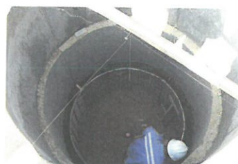
人工挖孔桩护壁
