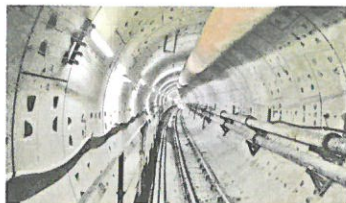
盾构衬砌完成
