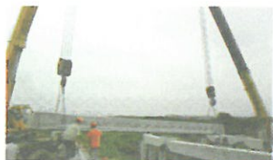
自行式吊机整孔架设法
