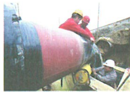
焊接管道强度试验
