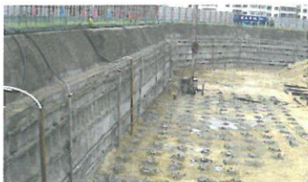
坑底加固和降水
