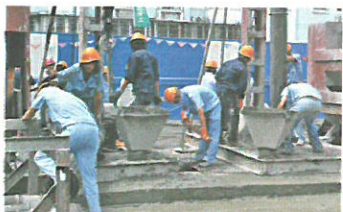
灌注水下混凝土
