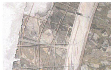
锚杆和钢筋网
