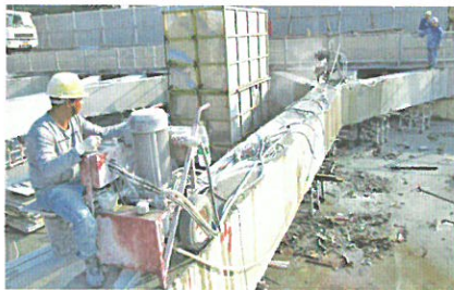
基坑支撑切割拆除
