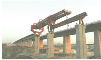
穿巷式架桥架梁法
