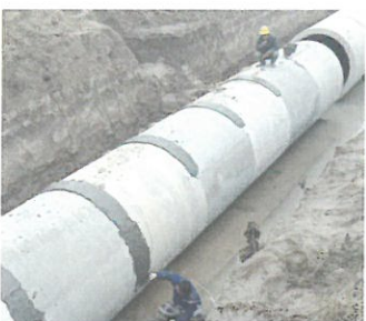
混凝土管刚性接口
