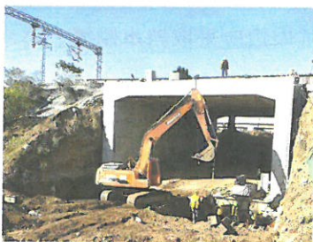
箱涵顶进挖土
