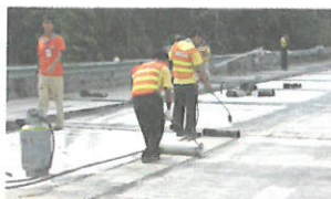
防水卷材施工
