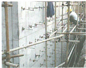
螺杆外露部分拆除
