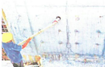
螺栓外露部分切割
