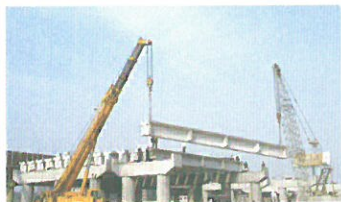
起重机架梁法
