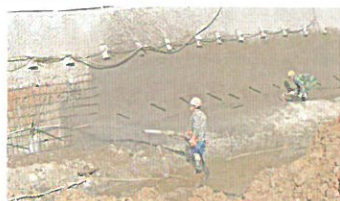
锚杆喷射混凝土护面
