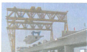
门架吊机整孔架设法
