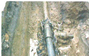
破管外挤（胀管法）
