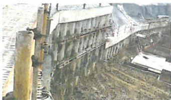
加大围护结构入土深度
