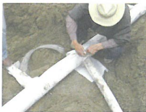
排水盲管安装
