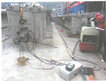
预应力张拉施工
