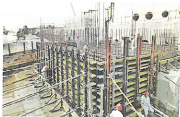
侧壁模板支撑
