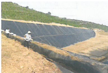
锚固沟回填土
