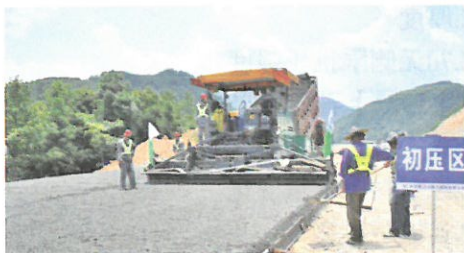
无机结合料稳定基层摊铺
