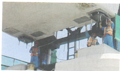
预制梁盆式支座安装
