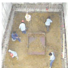
人工挖土下沉
