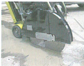
缩缝切割施工
