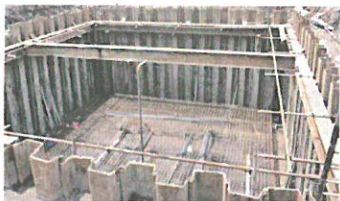
U型钢板桩围护结构
