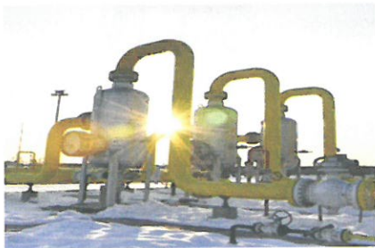
燃气管网附属设备安装
