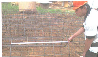
钢筋笼尺寸检测
