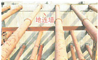
地连墙施工完成
