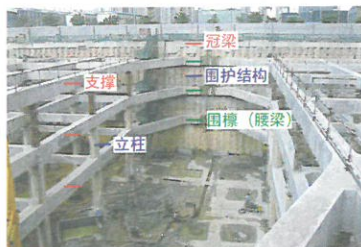
基坑整体构件图
