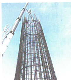
钢筋笼吊入孔
