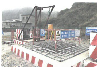
孔口安全防护
