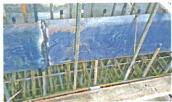
钢板止水带焊接
