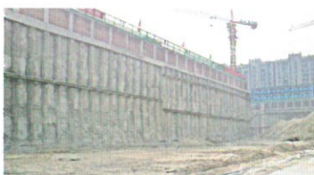
灌注桩围护结构
