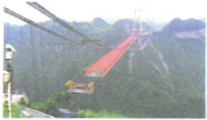
缆索吊机拼装架设法
