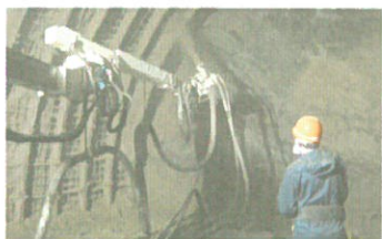
钢拱锚喷混凝土支护
