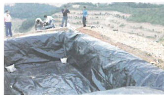
土工膜隔离防渗
