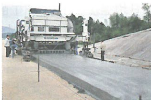
滑模摊铺机施工
