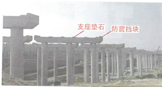
支座垫石和防震挡块
