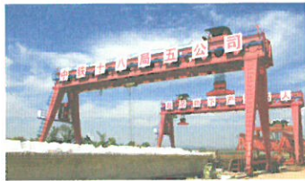
跨墩龙门吊架梁法
