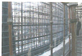
无粘结预应力筋布置
