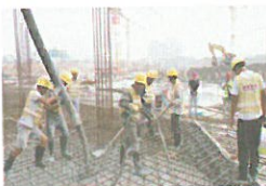
混凝土浇筑
