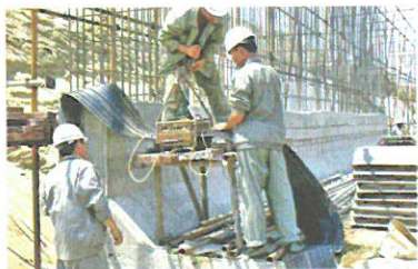
止水带焊接接长
