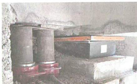
橡胶支座安装
