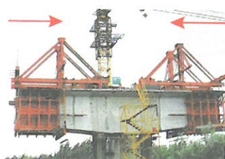
悬臂浇筑 (箭头指向为混凝土浇筑方向)
