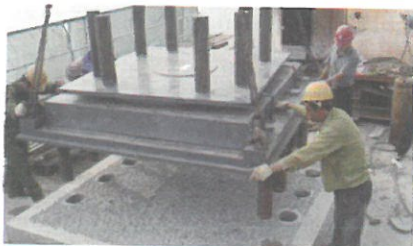
现浇梁盆式支座安装
