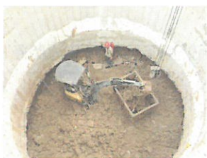
机具挖土下沉
