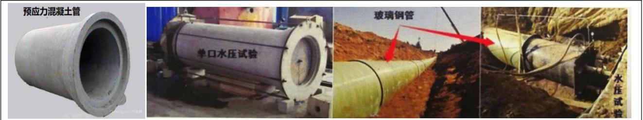
1. 分为**预试验**和**主试验**阶段；试验合格的判定依据分为**允许压力降**值和**允许渗水量**值，按设计要求确定。设计无要求时，应根据工程实际情况，选用其中一项值或同时采用两项值作为试验合格的最终判定依据；水压试验合格的管道方可通水投入运行。
