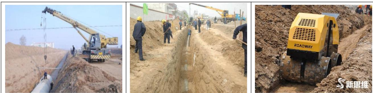
1. 当管道位于路基范围内时，其沟槽的回填土压实度应符合规范规定，且管顶以上 50cm 范围内不得使
