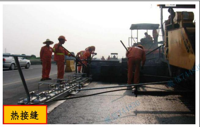
3. **高等级道路**的表面层横向接缝应采用垂直的**平接缝**，以下各层和其他等级的道路的各层可采用**斜接缝**。平接缝宜采用机械切割或人工刨除层厚不足部分，使工作缝成直角连接。清除切割时留下的泥水，干燥后**涂刷粘层油**，**铺筑新混合料**，**接槎软化后**，**先横向碾压**，再纵向充分压实，连接平顺。
