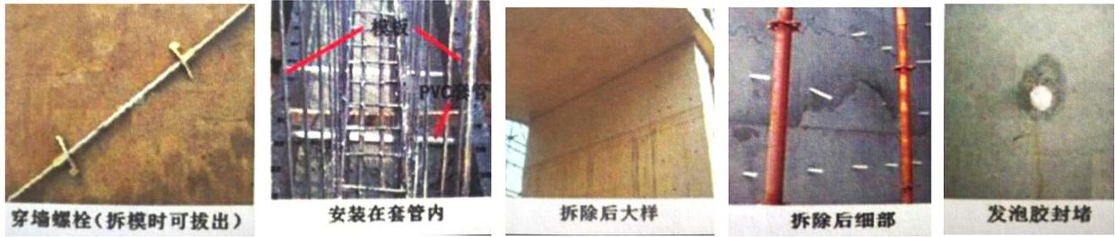
4. 池壁模板施工时, 应设置确保墙体顺直和防止浇筑混凝土时模板倾覆的装置。
