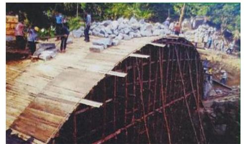
3. **模板、支架和拱架拆除**应遵循**先支后拆、后支先拆**的原则。支架和拱架应按几个循环卸落，**卸落量宜由小渐大**。每一循环中，在横向应同时卸落、在纵向应**对称均衡卸落**。**简支梁、连续梁**结构的模板应从**跨中**向**支座方向**依次循环卸落；**悬臂梁**结构的模板宜从**悬臂端开始**顺序卸落。★
