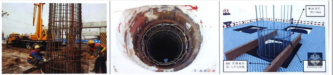
3. 沉管灌注桩**钢筋笼**内径应比套管内径小 60~80mm，用导管灌注水下混凝土的桩**钢筋笼内径**应比导管连接处的外径大 100mm 以上。
