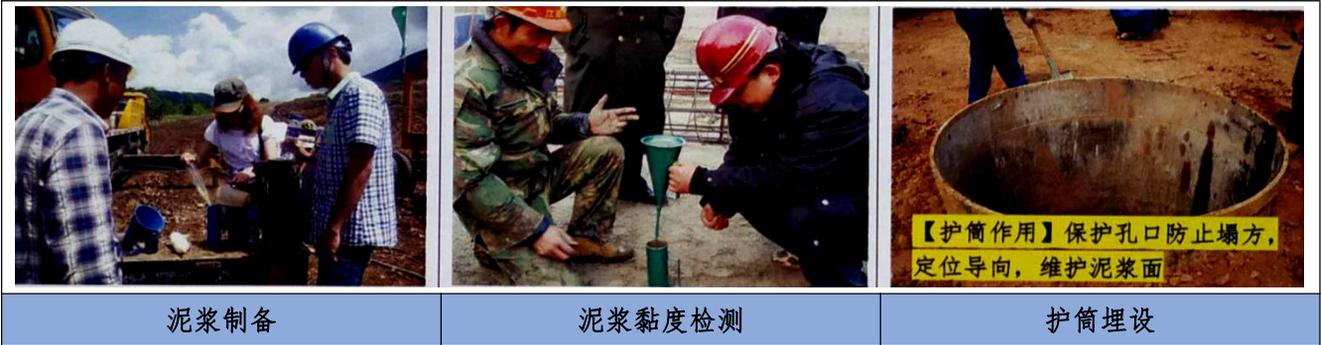
【护筒作用】保护孔口防止塌方，定位导向，维护泥浆面
