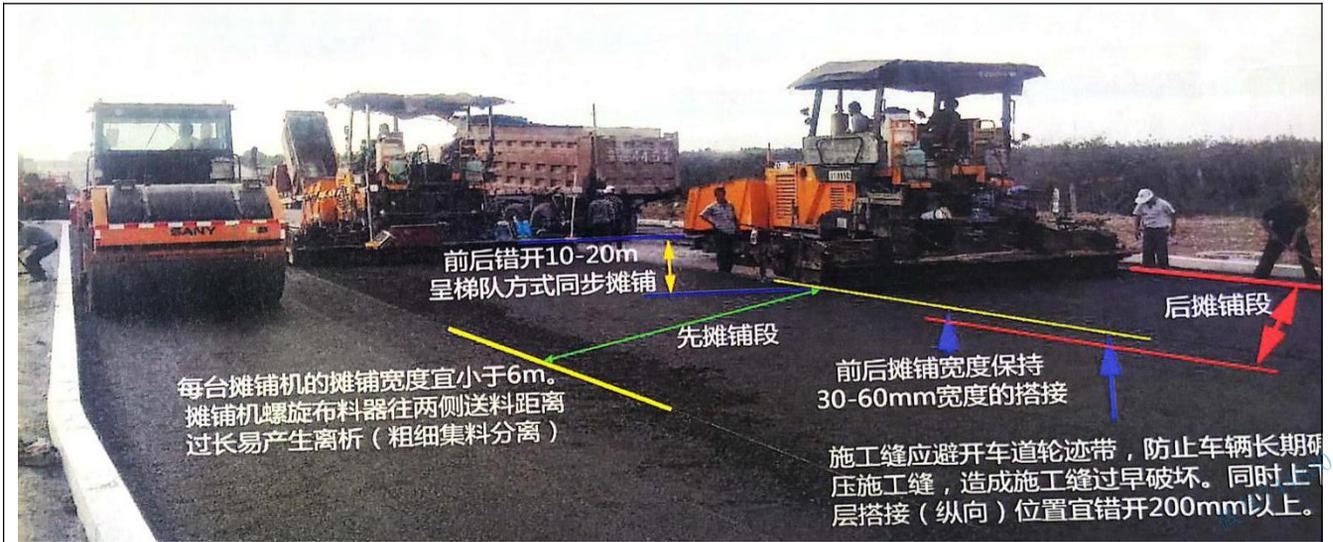
3. 摊铺机开工前应提前0.5~1h预热摊铺机熨平板使其不低于100℃。铺筑时熨平板振捣或夯实装置应选择适宜的振动频率和振幅，以提高路面初始压实度。
