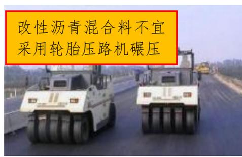
4. 振动压路机应遵循“紧跟、慢压、高频、低幅”的原则，即紧跟在摊铺机后面，采取高频率、低振幅的方式慢速碾压。这也是保证平整度和密实度的关键。压路机的碾压速度参照表 1K411041-2。如发现改性沥青 SMA 混合料高温碾压有推拥现象，应复查其级配。且不得采用轮胎压路机碾压，以防混合料被搓擦
