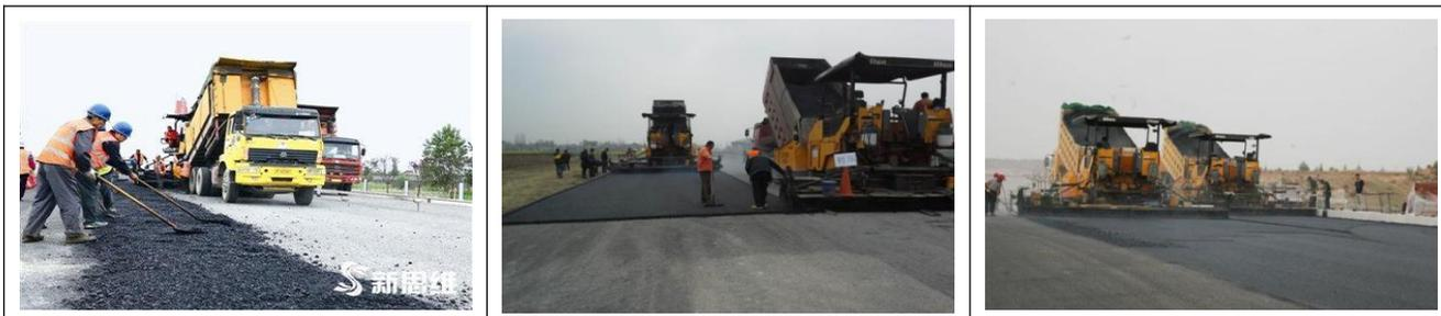
1. 在喷洒有粘层油的路面上铺筑改性沥青混合料时，宜使用履带式摊铺机。改性沥青 SMA 混合料施工温度应经试验确定，一般情况下，摊铺温度不低于 160℃。
