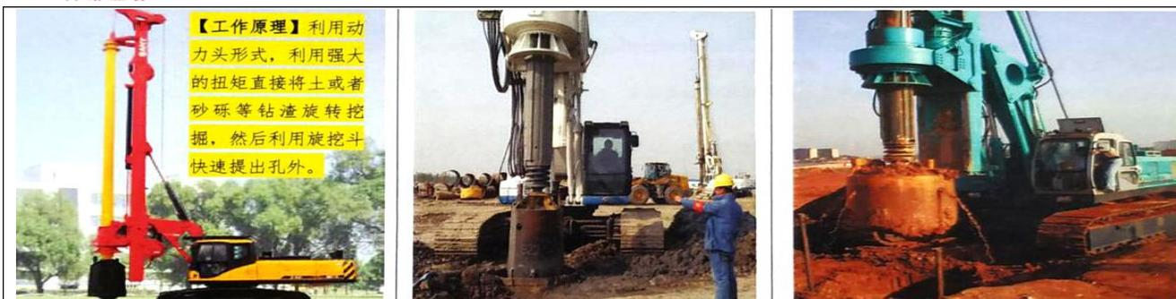
**【工作原理】**利用动力头形式，利用强大的扭矩直接将土或者砂砾等钻渣旋转挖掘，然后利用旋挖斗快速提出孔外。
