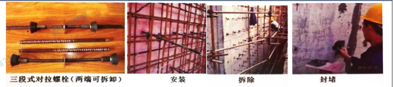
三段式对拉螺栓（两端可拆卸）
