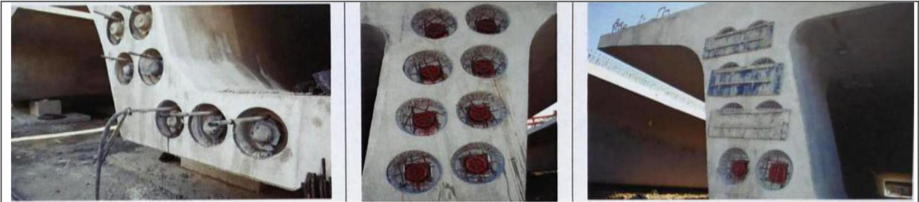
1. 预应力筋张拉后，应及时进行孔道压浆，多跨连续有连接器的预应力筋孔道，应张拉完一段灌注一段。孔道压浆宜采用水泥浆。水泥浆的强度应符合设计要求，设计无要求时不得低于 30MPa。
