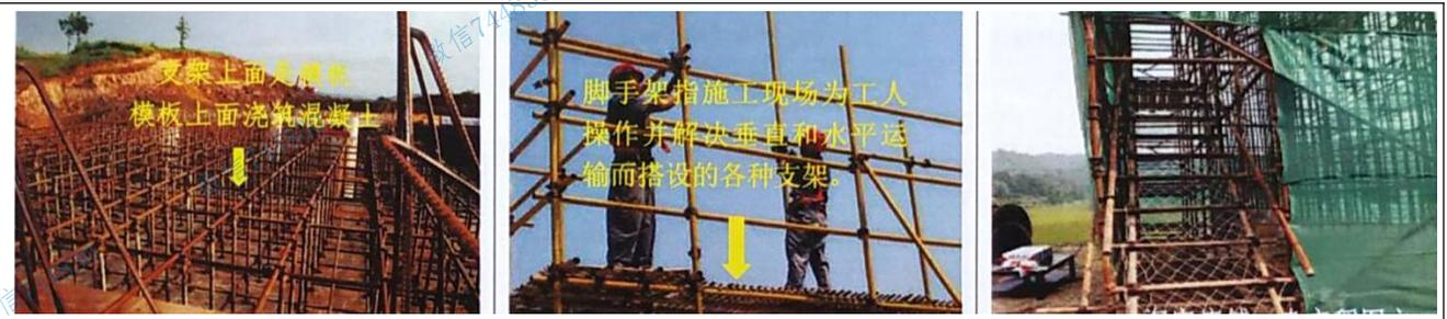
6. 钢管满堂**支架**搭设完毕后，应按要求，**预压**合格并形成记录。（**预压目的**：**消除拼装间隙和地基沉降**）
