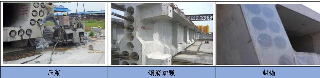
1. 张拉后，应及时进行孔道压浆，宜采用**真空辅助法压浆**；水泥浆的强度应符合设计要求，且不得低于**30MPa**。
