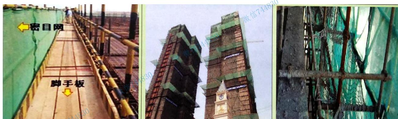
3. 严禁在脚手架上拴缆风绳、架设混凝土泵等设备。
