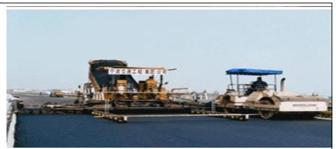
6. 最低摊铺温度根据铺筑层厚度、气温、风速及下卧层表面温度（下卧层即下一面层，或称下承层）等，按规范要求执行。例如，铺筑普通沥青混合料，下卧层的表面温度为15~20℃，铺筑层厚度为小于50mm、50~80mm、大于80mm三种情况下，最低摊铺温度分别是140℃、135℃、130℃。
