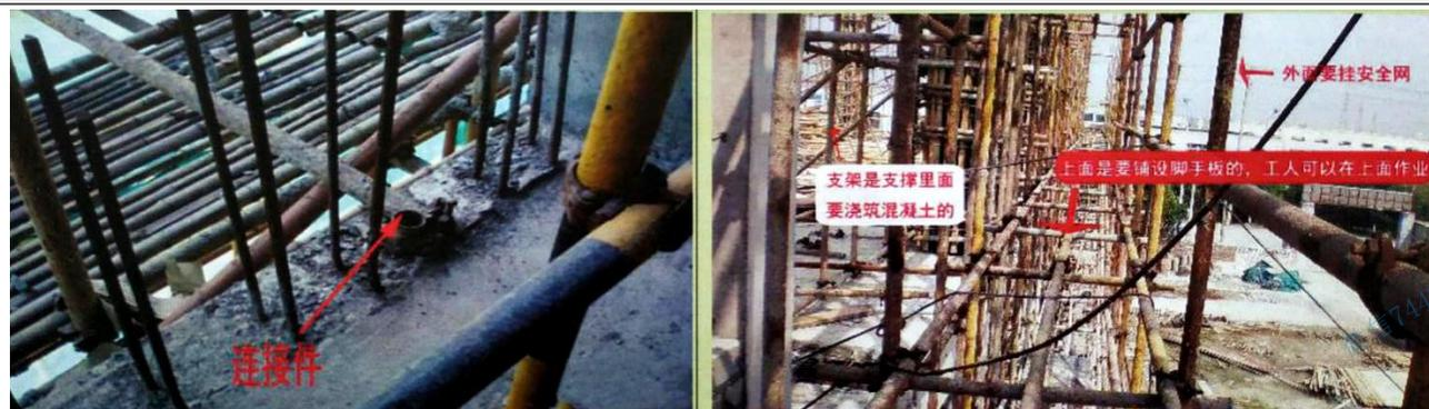
2. 作业平台上的**脚手板**必须在脚手架的宽度范围内**铺满、铺稳**。作业平台下应设置**水平安全网**或**脚手架防护层**，防止高空物体坠落造成伤害。
