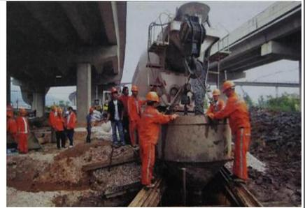
6. **桩顶混凝土**浇筑完成后应**高出设计标高 0.5~1m**，确保桩头浮浆层凿除后桩基面混凝土达到设计强度。
