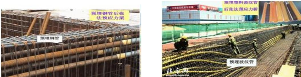
(4) 管道安装就位后应立即通孔检查，发现堵塞应及时疏通。管道经检查合格后应及时将其端面封堵，防止杂物进入；
