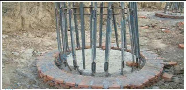
**主要原因**是超灌高度不够、混凝土浮浆太多、孔内混凝土面测定不准。
