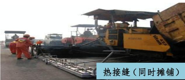
1. 改性沥青混合料路面冷却后很坚硬，冷接缝处理很困难，因此应**尽量避免**出现**冷接缝**。
