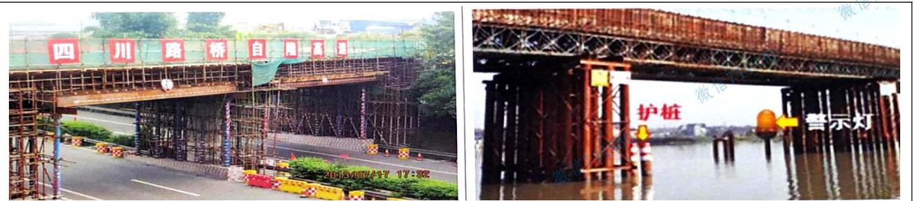
4. 安设**支架、拱架**过程中，应随安装随架**临时支撑**。采用**多层**支架时，**支架的横垫板**应水平，**立柱**应铅直，**上下层立柱**应在同一**中心线**上。
