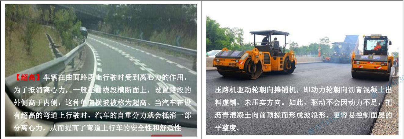
**【超高】**车辆在曲面路段上行驶时受到离心力的作用，为了抵消离心力，一般在曲线段横断面上，设置路段的外侧高于内侧，这种单向横坡被称为超高。当汽车在设有超高的弯道上行驶时，汽车的自重分力就会抵消一部分离心力，从而提高了弯道上行车的安全性和舒适性
