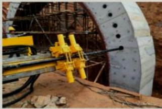
水平钻孔
