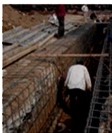
导墙钢筋绑扎
